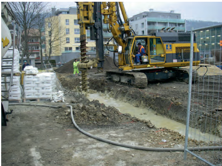
Fig. 5: Exécution de l'enceinte de confinement selon la technique «Mixed In Place».
