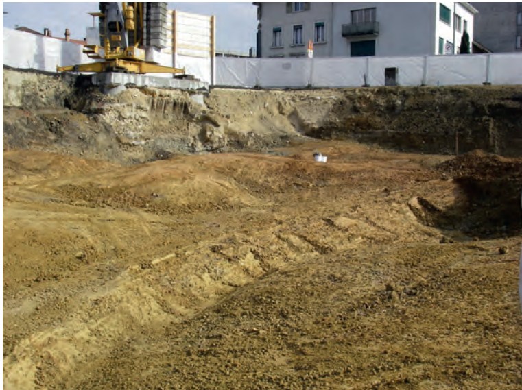
Fig. 9: Surface du toit de la molasse marneuse au terme des excavations.
