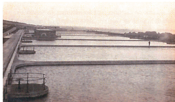
Fig. 1 Filtre lent à Arlington, Angleterre Langsamsandfilter in Arlington, UK
