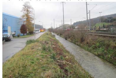
Porrentruy, lit de la rivière (état avant travaux)
