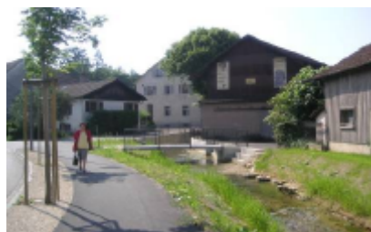
Photo 1 : Mise à ciel ouvert dans le secteur St.-Germain à Porrentruy
