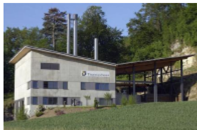
Cliché pris a Centrale du Thermoréseau
