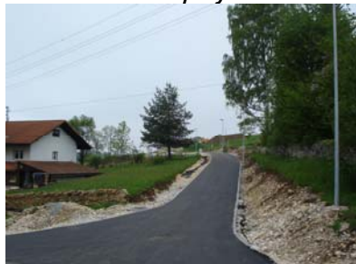
Raccordement sur la rue des Rotchets
