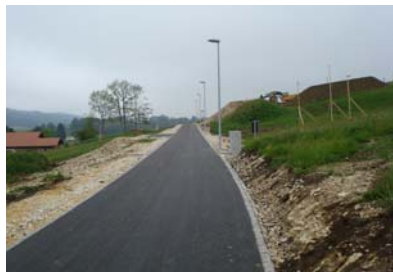
Lotissement Clos Miserez 2 après les travaux
