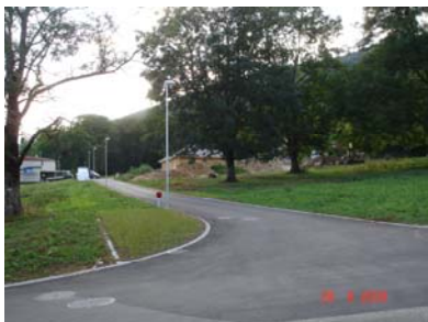
Lotissement du « Chênois » après les travaux
