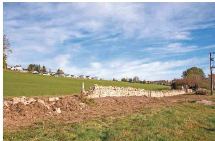
Une cinquantaine de mètres de mur en pierre sèche a d'ores et déjà été reconstruite.
