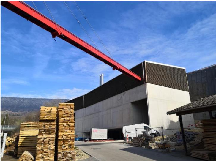
Transport du bois entre la scierie et la nouvelle centrale de chauffage à distance par convoyeur aérien de 60 m haubané :
